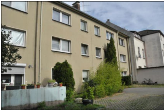
Hofansicht, links Kelleraußentreppe
