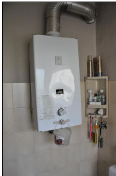
Gasdurchlauferhitzer
