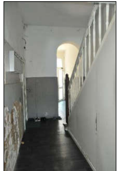
Treppenhaus Erdgeschoss Blickrichtung Haustüre
