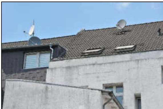
Dacheindeckung Hofseite Vorderhaus
