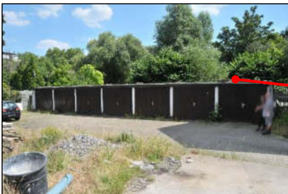
Garagenzeile, rechts Durchgang Hofgebäude HsNr. 222a
