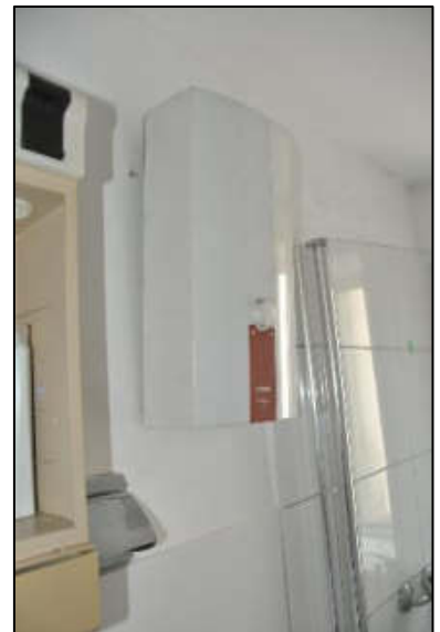
erneuerter Durchlauferhitzer
