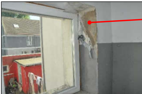
Fenster Treppenhaus 1. OG
