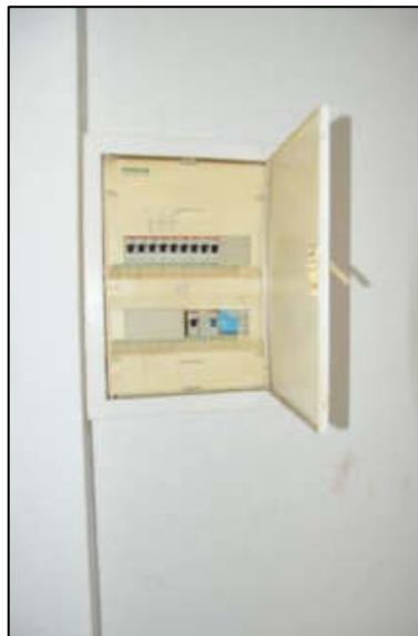
Sicherungskasten
