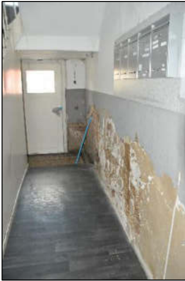
Durchgang zum Hof, links Zugang Kellergeschoss
