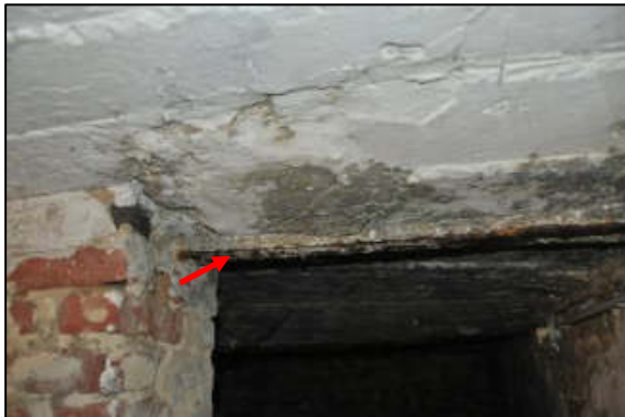
verrosteter Stahlträger
