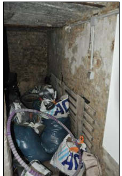
Bereich unter der Kellertreppe
