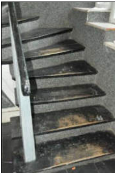
Zustand Treppe Erdgeschoss
