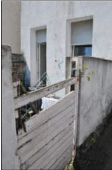
Links tiefer liegender Hofbereich HsNr. 222
