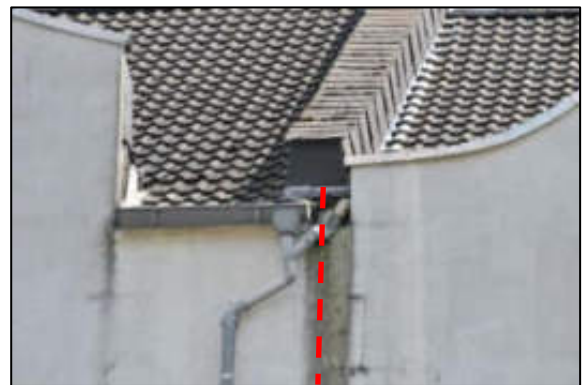
Dachentwässerung über Fallrohr HsNr. 220
