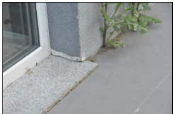
Ausführung / Abdichtung feststehende Verglasung
