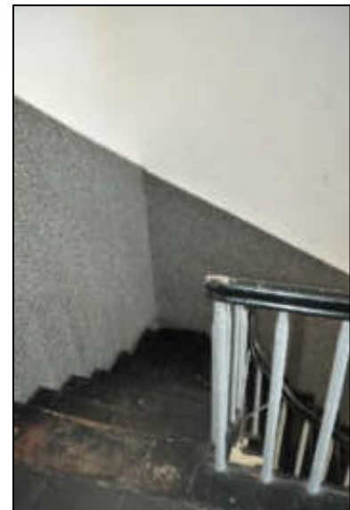
Zustand Treppe im Obergeschoss
