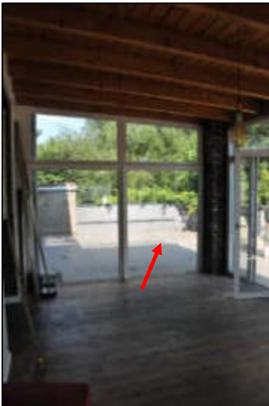
Wintergarten, Blickrichtung Überbauung Terrasse Im Hintergrund Grenzmauer
