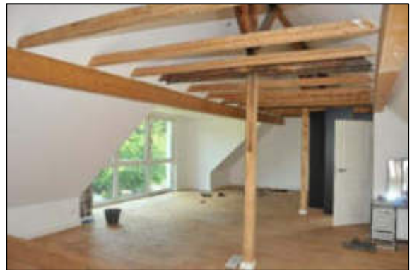
Offener Raum im Dachgeschoss
