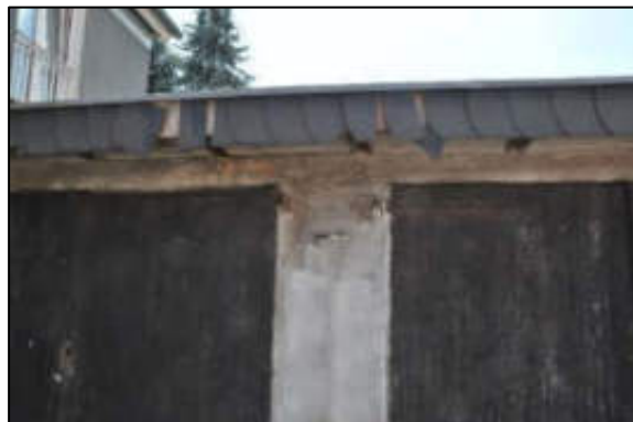
Detail Zustand Fassade
