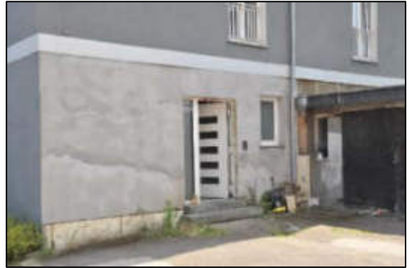
Hauseingang Duisburger Str. 222a, rechts Garagenzeile
