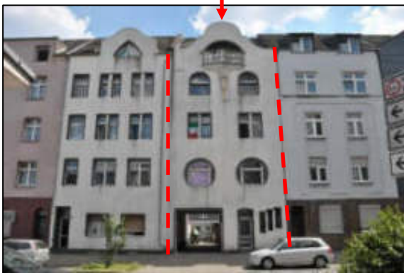
Straßenansicht Duisburger Straße 222
