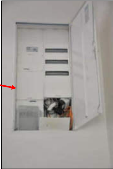
Sicherungskasten
