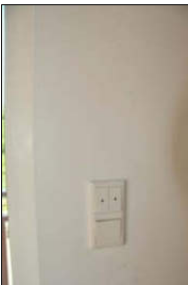
Schalter Rollläden (nur Elektrik, Rollläden fehlen noch)
