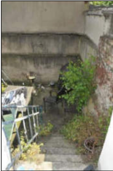
Zugang Wohnung EG zum tiefer liegenden und eingefassten Hofbereich
