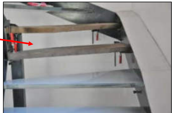
provisorische Ersatzstufen
