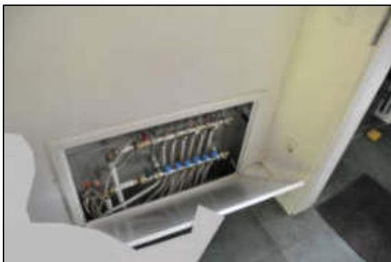
Verteiler Fußbodenheizung
