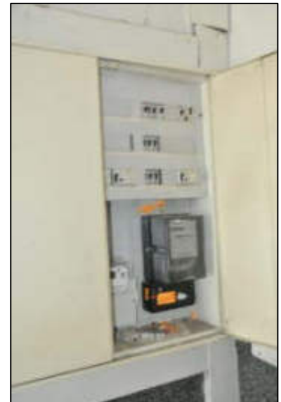
Zählerkasten im Hausflur
