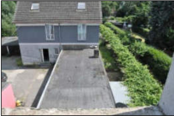
Draufsicht Garagenzeile rechts und Hinterhaus 222a
