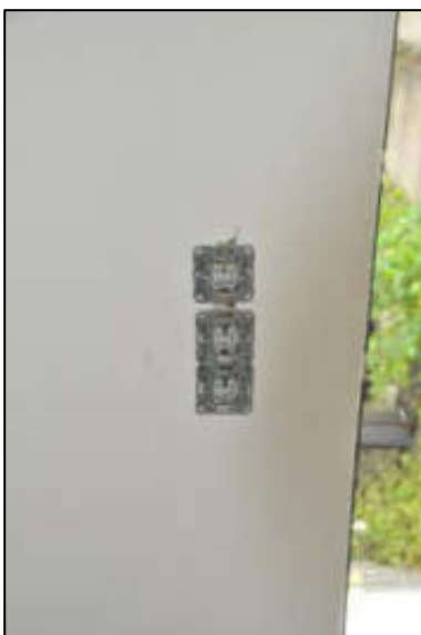
fehlende Schalterabdeckungen
