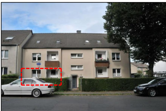
Straßenansicht Taunusstraße 146 Markierung = ETW 1
