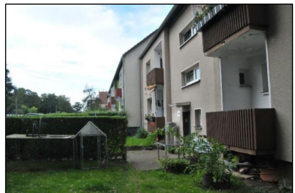
Vorgarten, Blickrichtung Nordwesten / HsNr. 148
