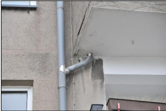
Allgemeinzustand Fallrohre und Balkonentwässerung
