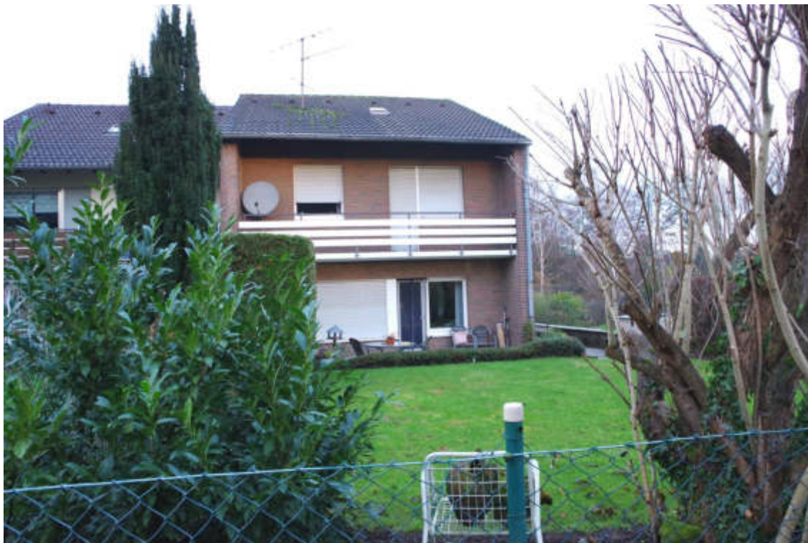
Bild 3: Rückansicht des Einfamilienhauses aus Süd
