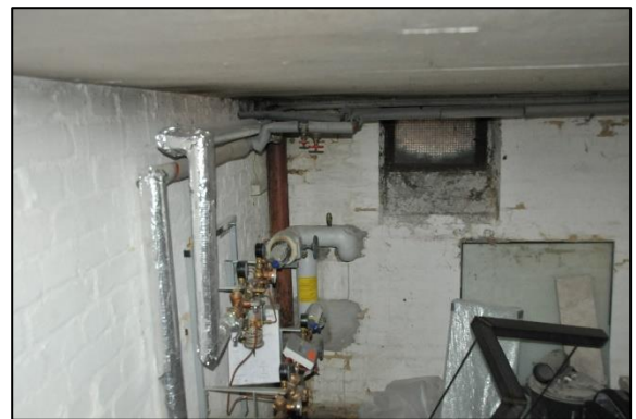
Fernwärmeanschluss
