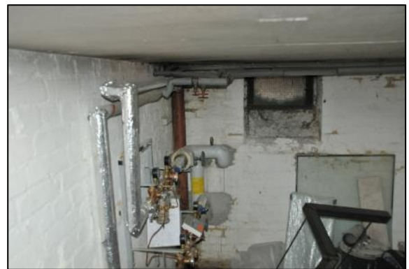
Fernwärmeanschluss
