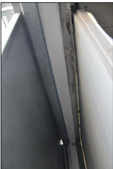
Rechts originales Holzschiebeter Links vorgesetztes neueres Metallschiebeter
