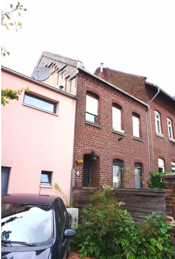
Bild 2: Straßenansicht des Einfamilienhauses aus Südost
