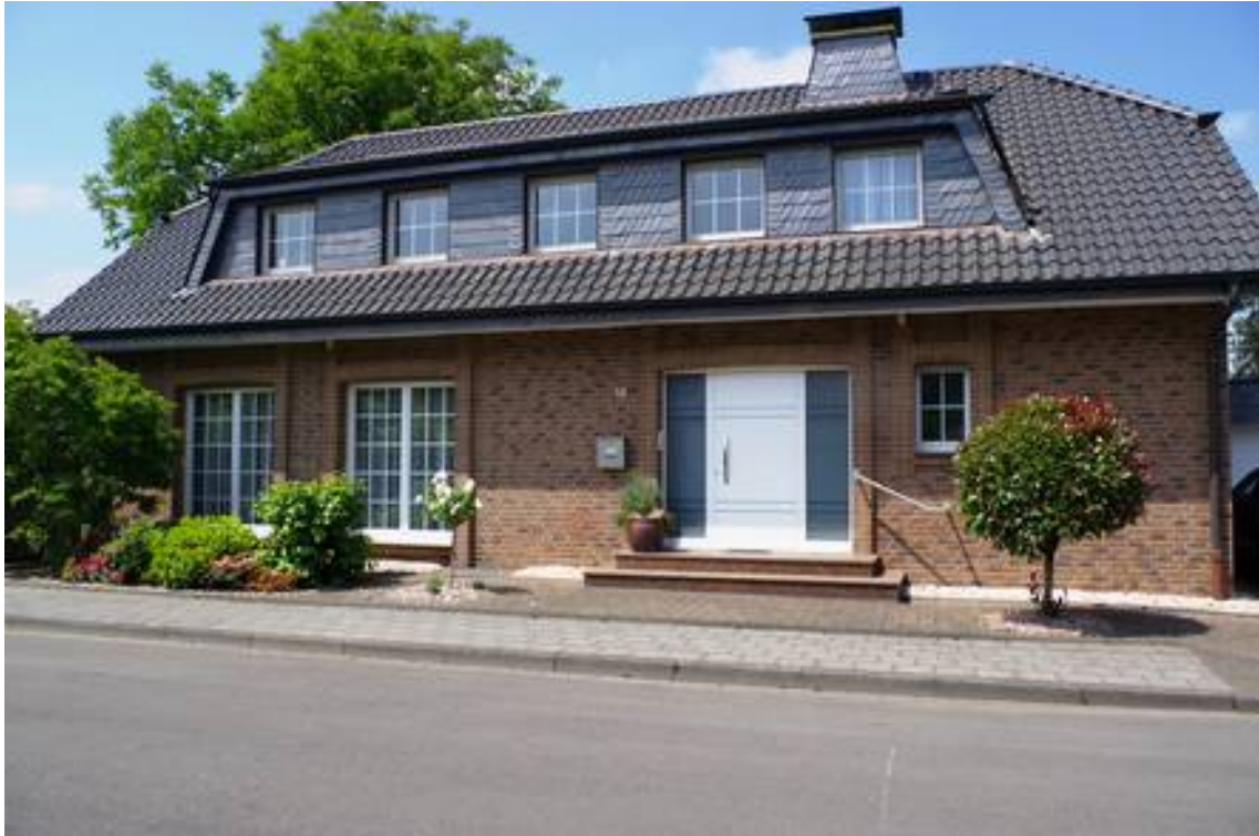
Bild 3: Straßenansicht des Einfamilienhauses aus Ost
