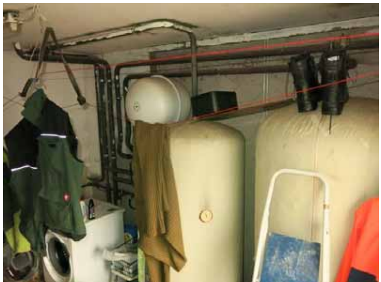
Beispiel Wohnhaus, 2 x elektrisch beheizte Speicher (Heizung und Warmwasser)
