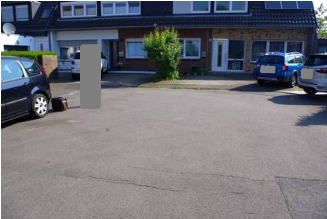
Bild 5: Blick in den Wendehammer in Richtung Nordost
