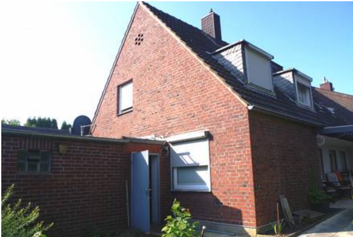
Bild 3: Giebelansicht des Zweifamilienhauses aus Nord
