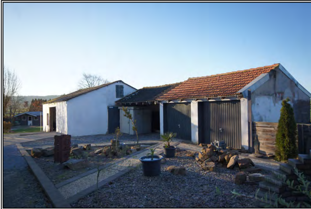
Blick auf die Nebengebäude
