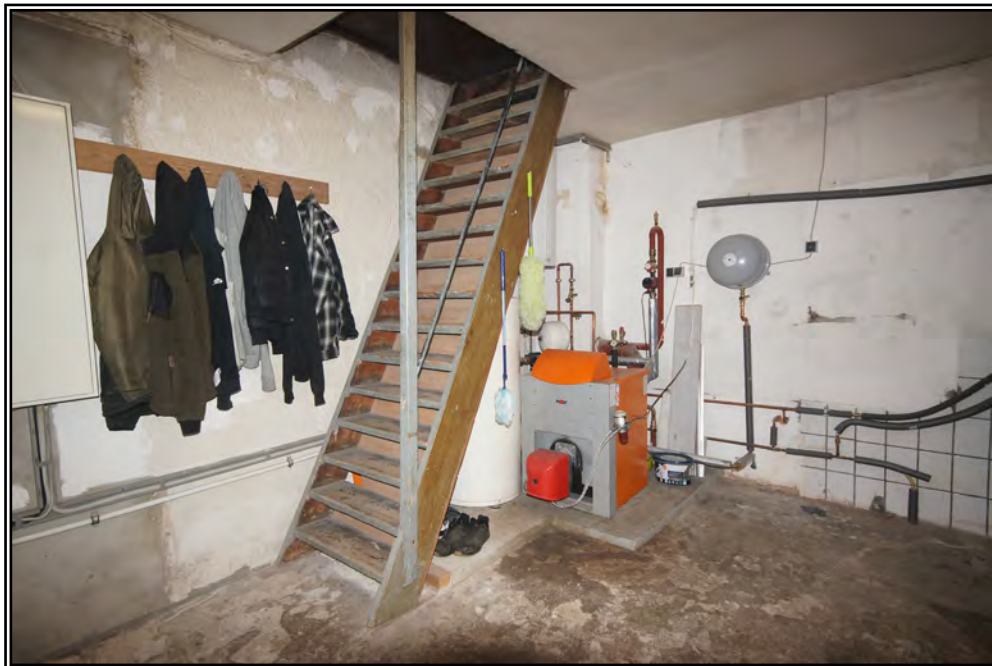
Rückwärtiger Eingangsbereich (Treppe zum Dachboden, Heizung, Waschküche)
