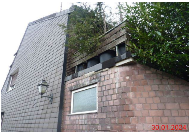
Abb. 9 rechte Giebelseite (von der Straße aus)
