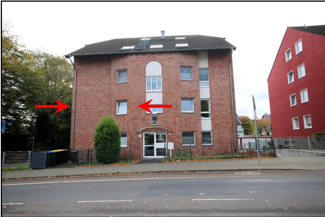
Bild 3: Ansicht von Norden
