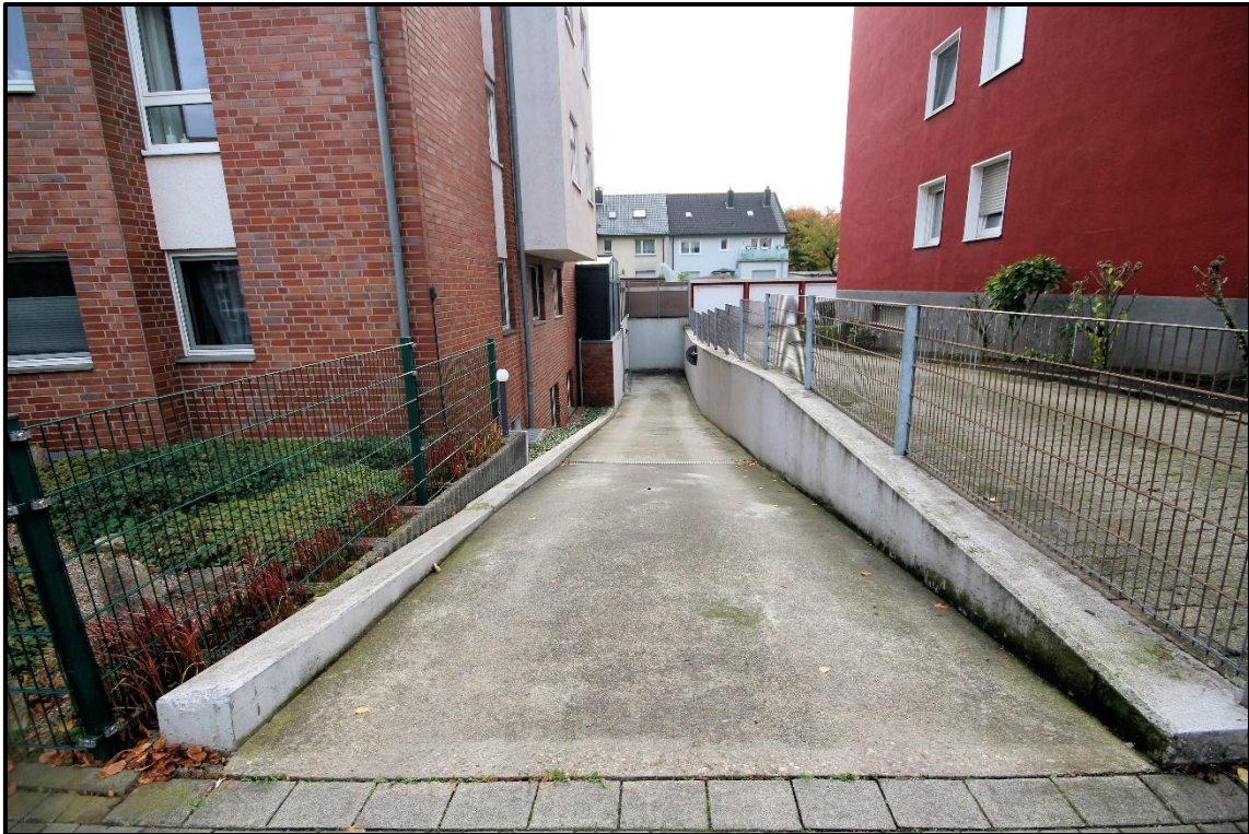
Bild 9: Ein- und Ausfahrt zur Tiefgarage
