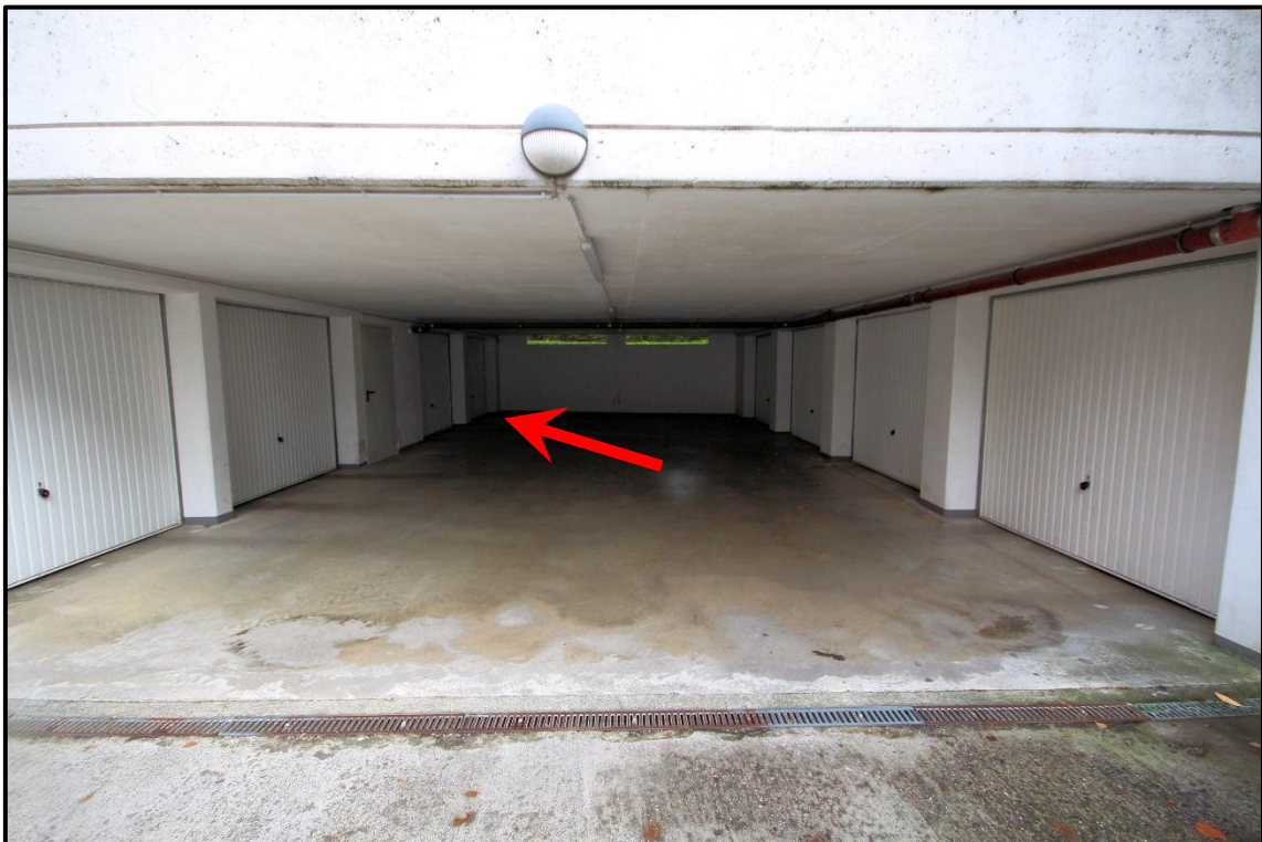
Bild 10: Tiefgarage (Einstellplatz Nr. 12 hinten links)
