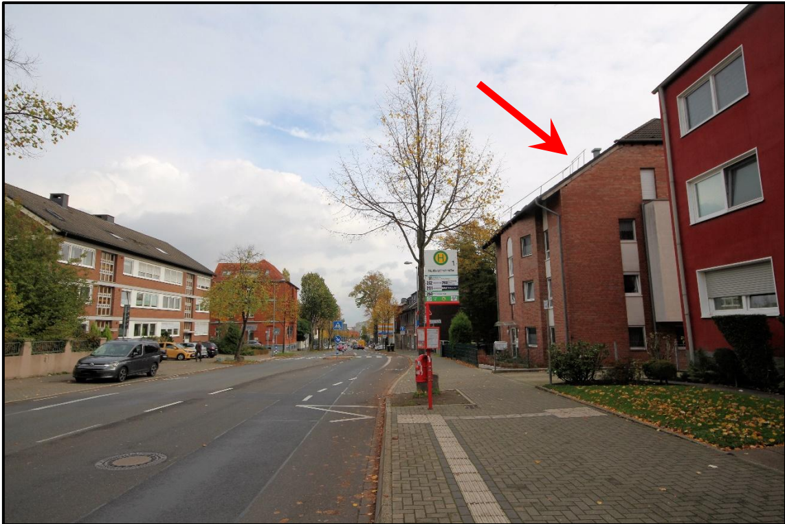
Bild 1: Blick in die Osterfelder Straße nach Osten
