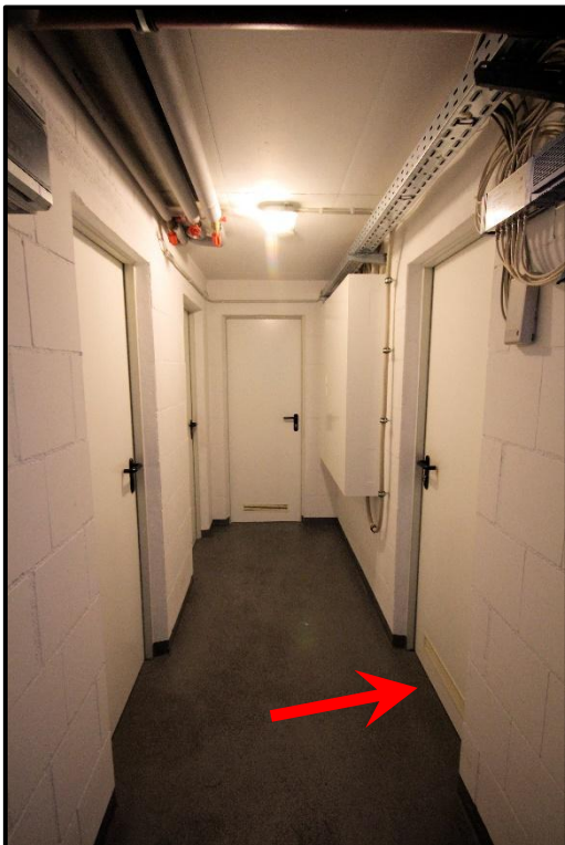
Bild 13: Kellerflur mit Keller Nr. 4 (roter Pfeil)
