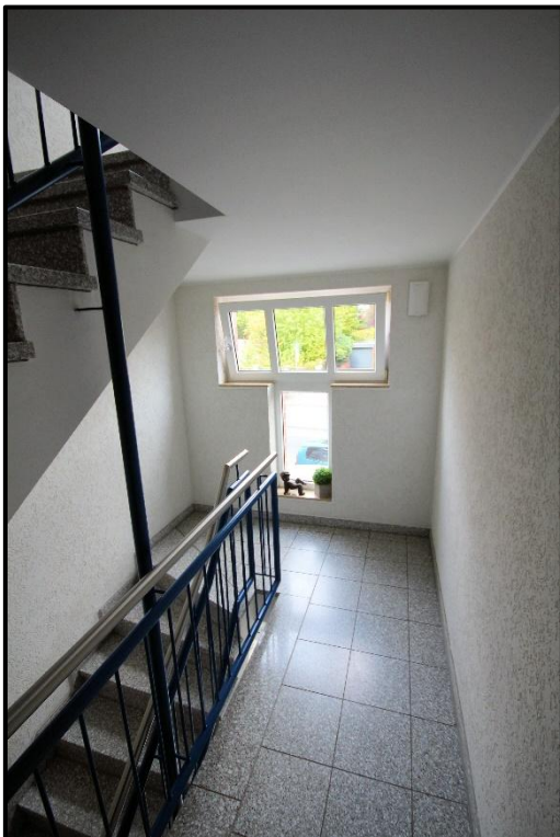
Bild 19: Treppenhaus im Obergeschoss
