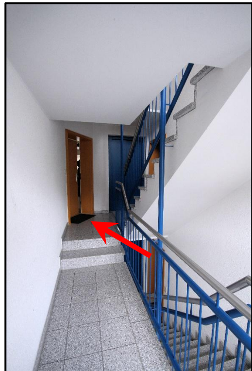
Bild 20: Wohnungstür der WE Nr. 4 (roter Pfeil)
