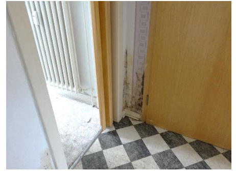
Detailaufnahmen Feuchteschaden (Flur)
