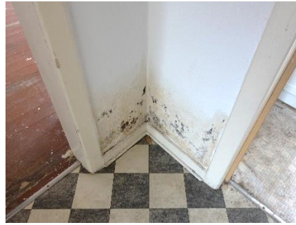
Detailaufnahmen Feuchteschaden (Flur)
