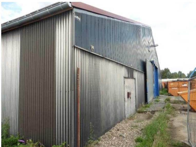
Südgiebel mit Schäden (Fallrohre / Fassade etc.)
