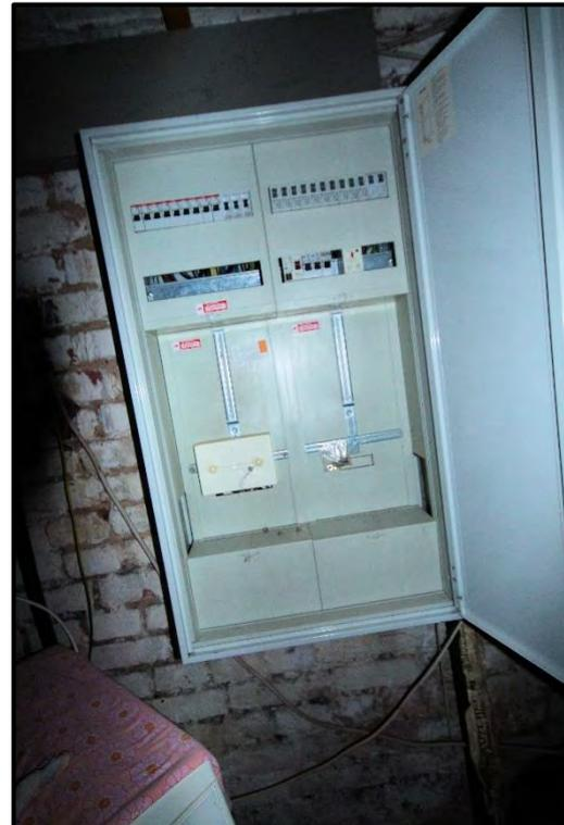
Bild 33: Zähler und Sicherungsschrank im
