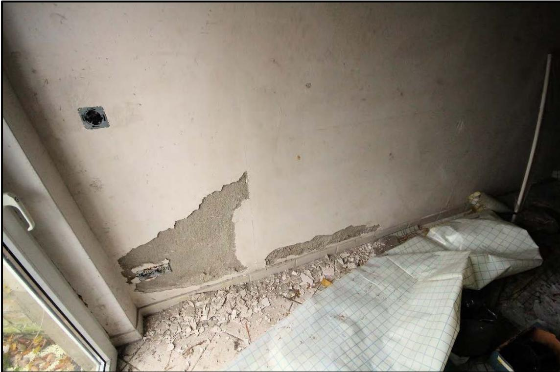
Bild 24: Feuchteschaden an der Trennwand zum Nachbaranbau. Laut Auskunft der beim Ortstermin anwesenden Miteigentümerin befindet sich dort im Nachbargebäude ein Badezimmer.
