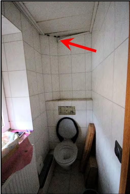
Bild 40: WC im Obergeschoss mit Feuchtschaden an der Wand über dem WC
