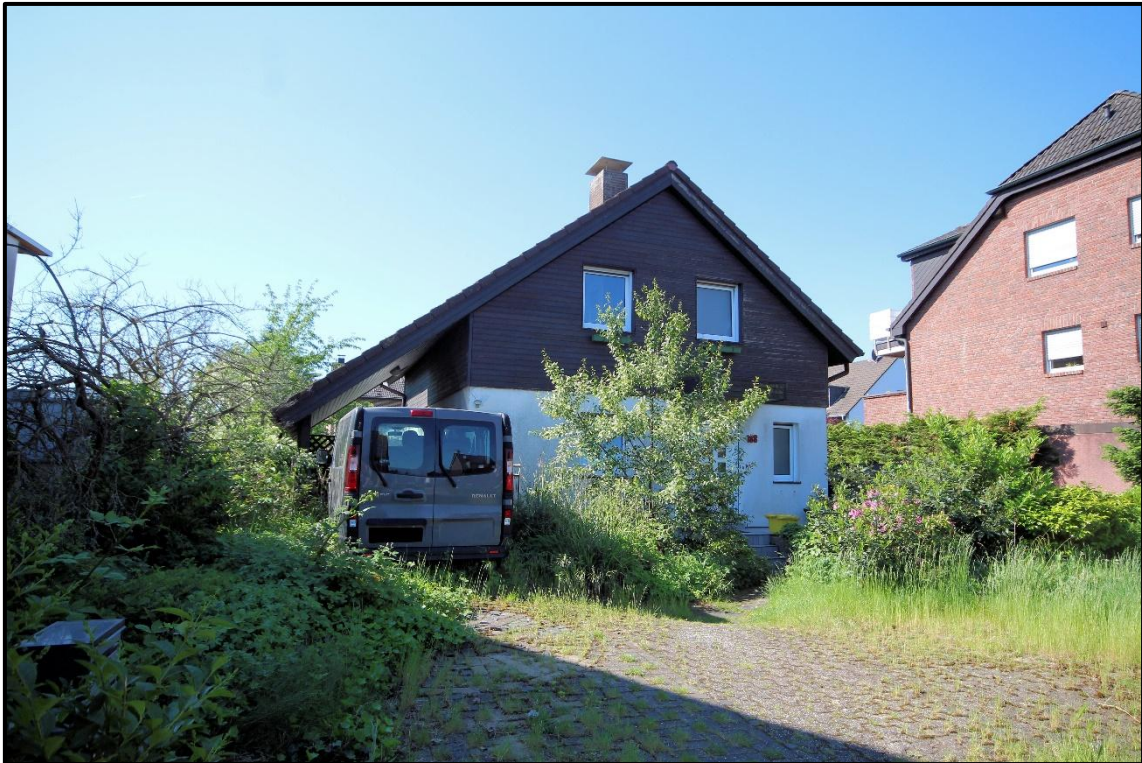
Bild 5: Ansicht von Nordosten
