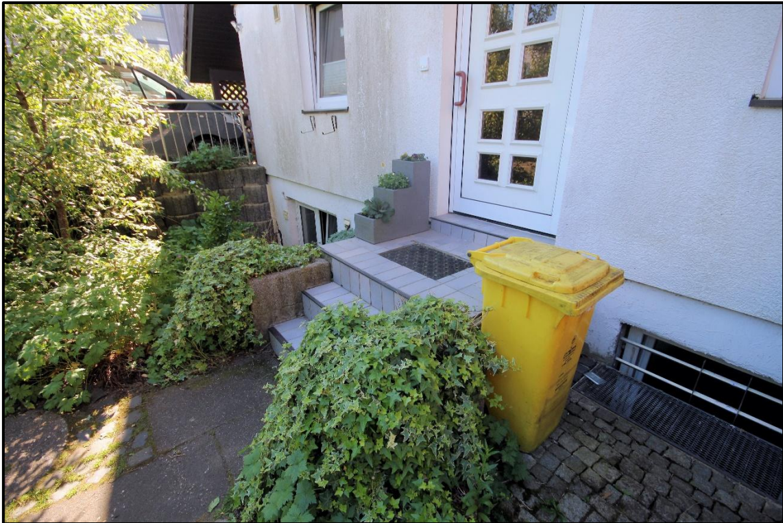
Bild 9: Eingangstreppe, Lichtgraben und Kellerlichtschacht
