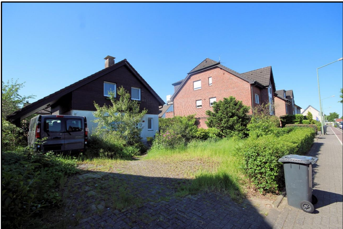
Bild 4: Ansicht von Nordosten
