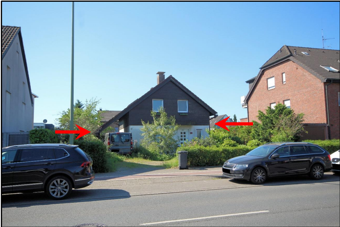
Bild 3: Ansicht von Norden
