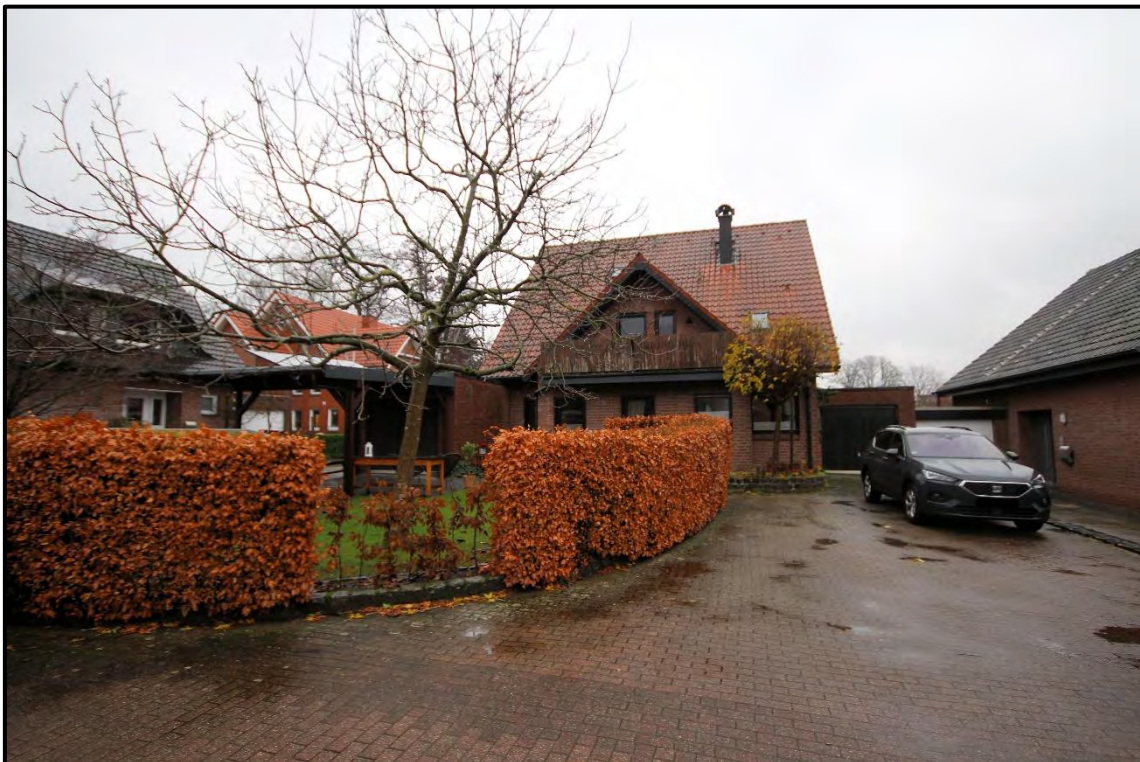
Bild 2: Ansicht von Westen
