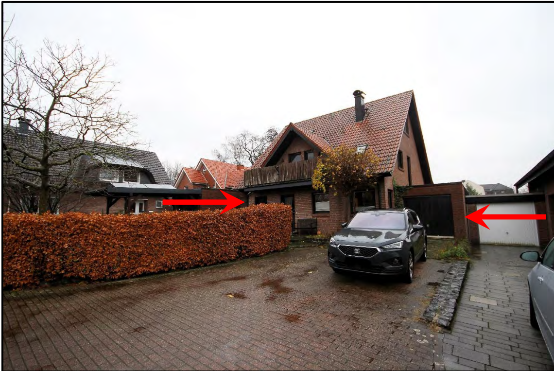
Bild 1: Ansicht von Südwesten
