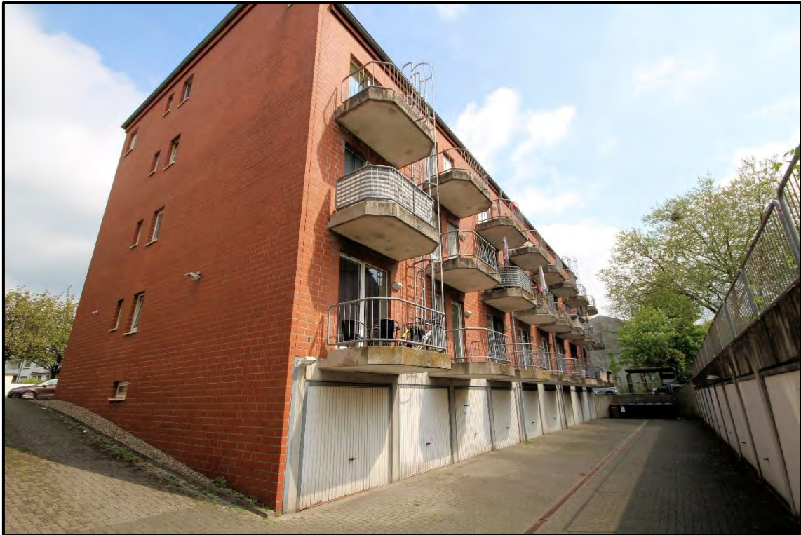
Bild 7: Ansicht von Südwesten
