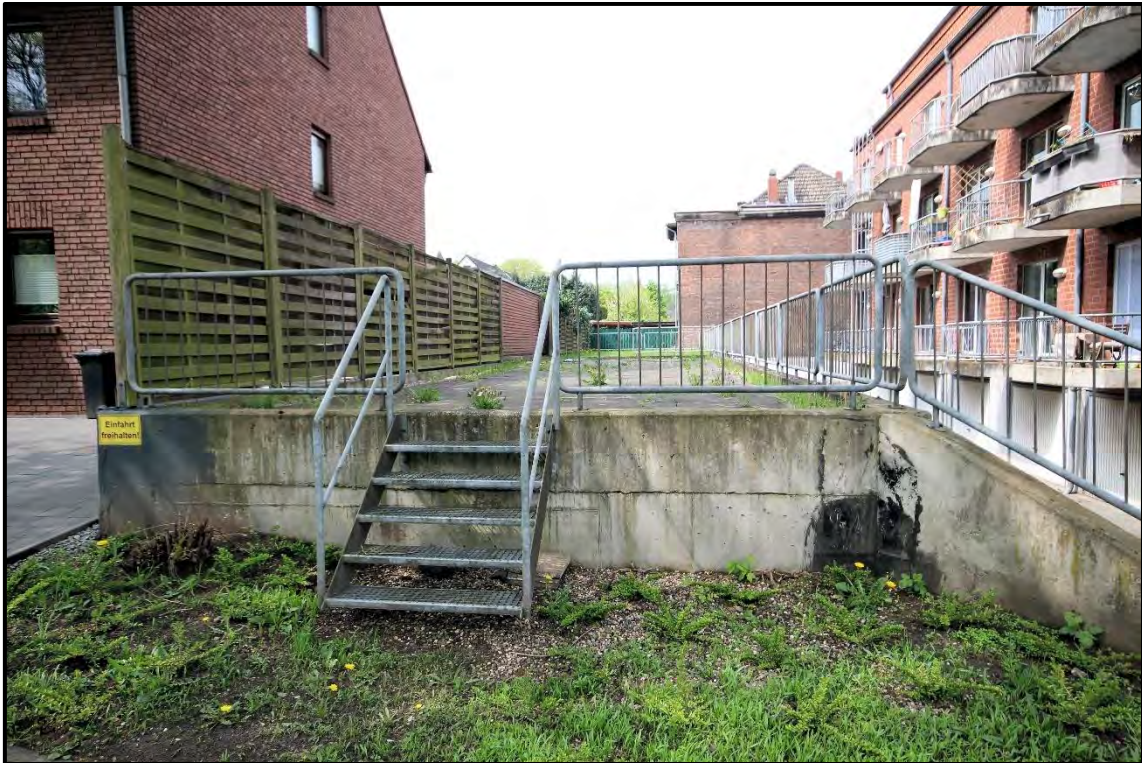
Bild 11: Zugang zum Garagendach
