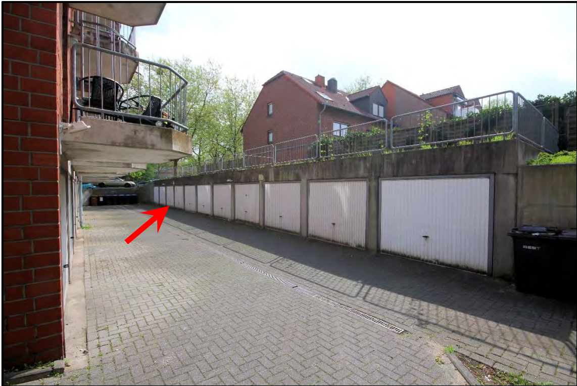
Bild 9: Blick in den Garagenhof mit zwei Garagenzeilen
