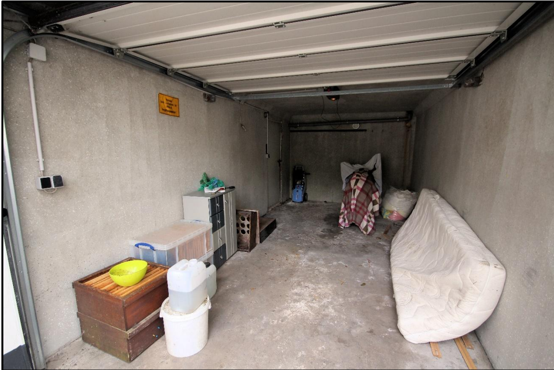
Bild 54: straßenseitig rechte Garage (ein Einstellplatz)
