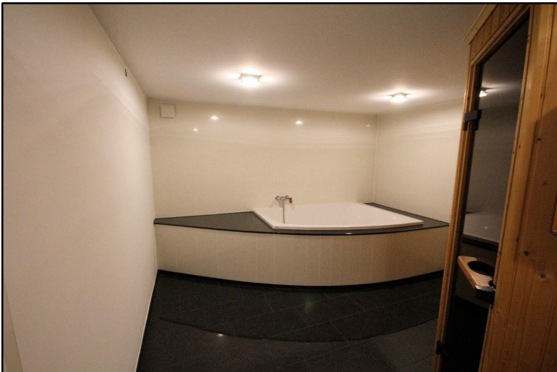
Bild 49: Saunabad im Kellergeschoss
