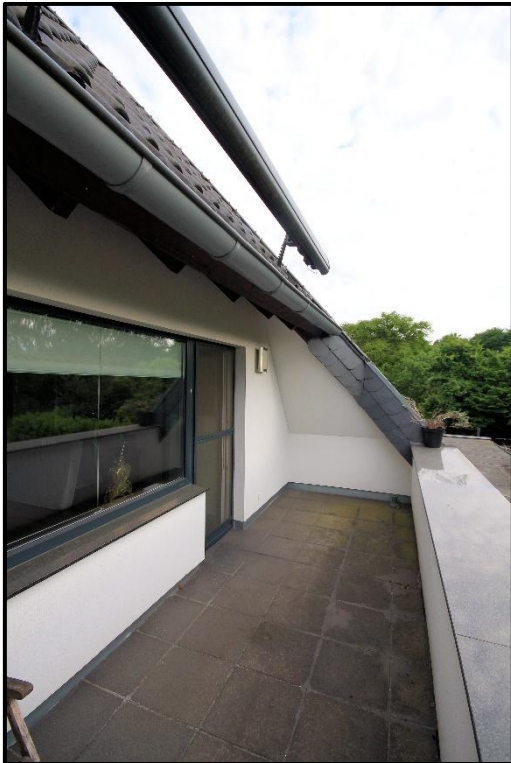
Bild 35: Dachterrasse der Wohneinheit im Dachgeschoss
