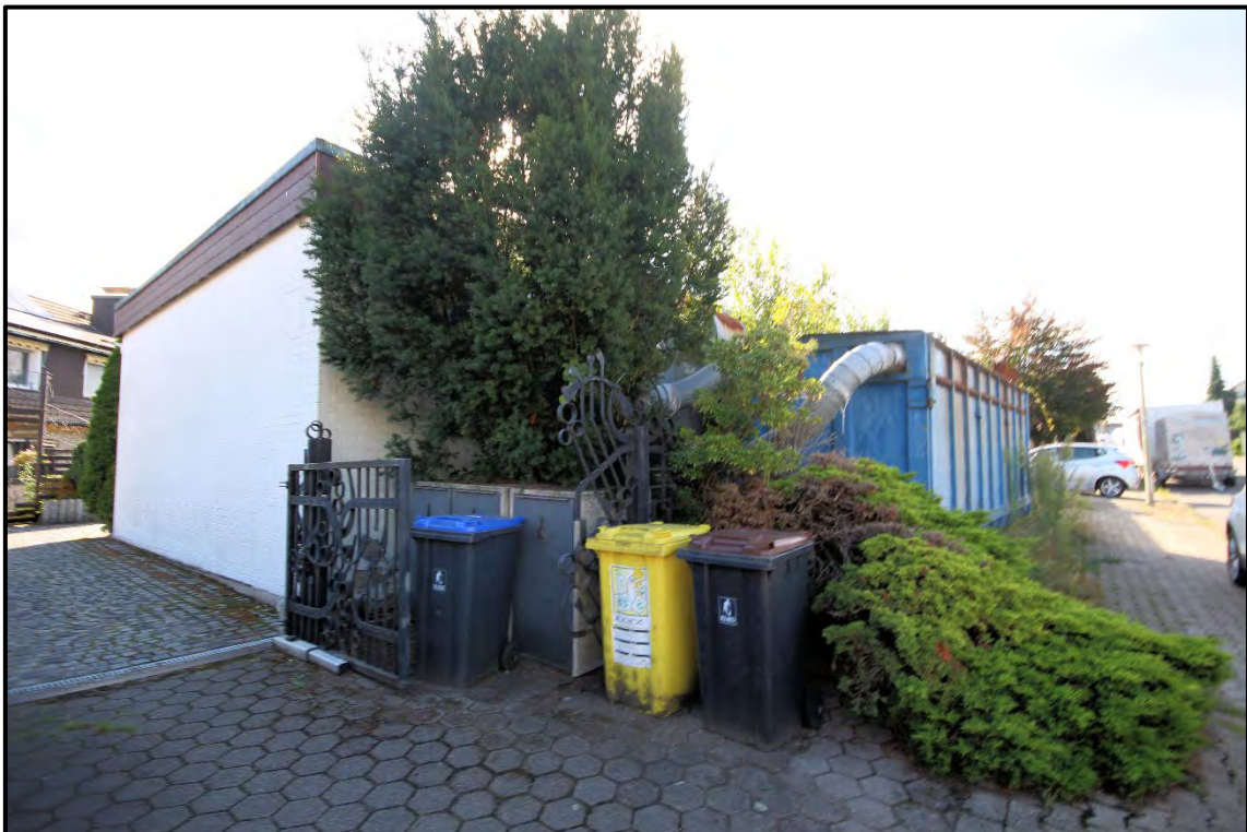
Bild 2: Ansicht Von-Braun-Straße 22 von Nordwesten
