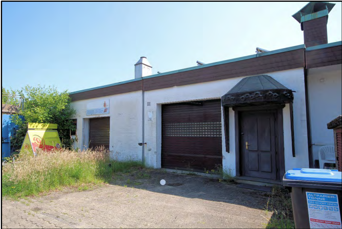
Bild 7: Ansicht von Südwesten
