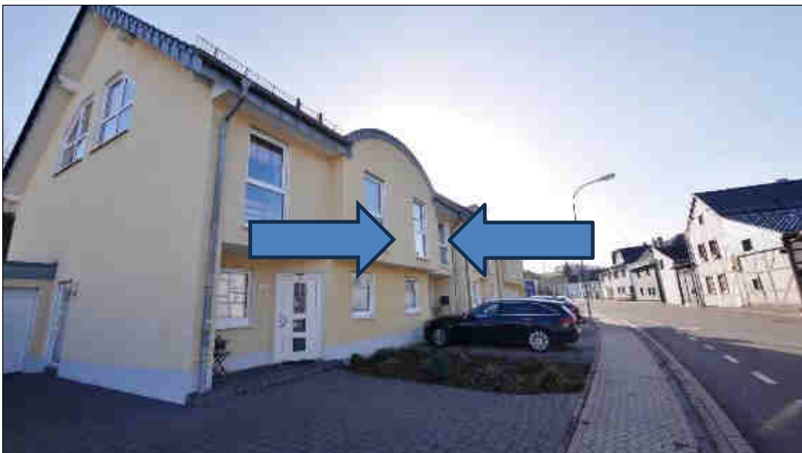
Bild 2: Blick in die Erschließungsstraße mit Bewertungsobjekt
