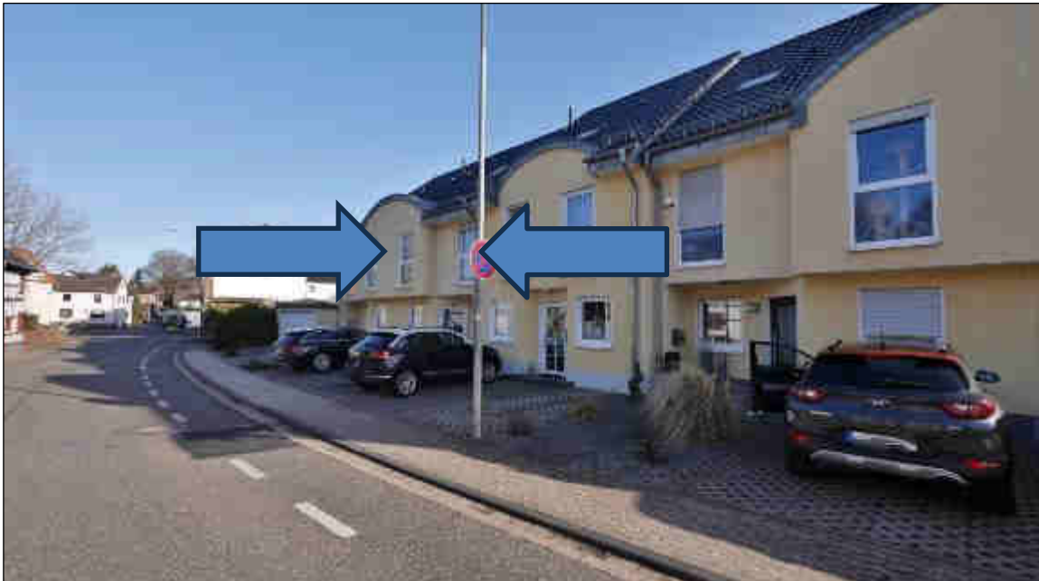
Bild 1: Blick in die Erschließungsstraße mit Bewertungsobjekt
