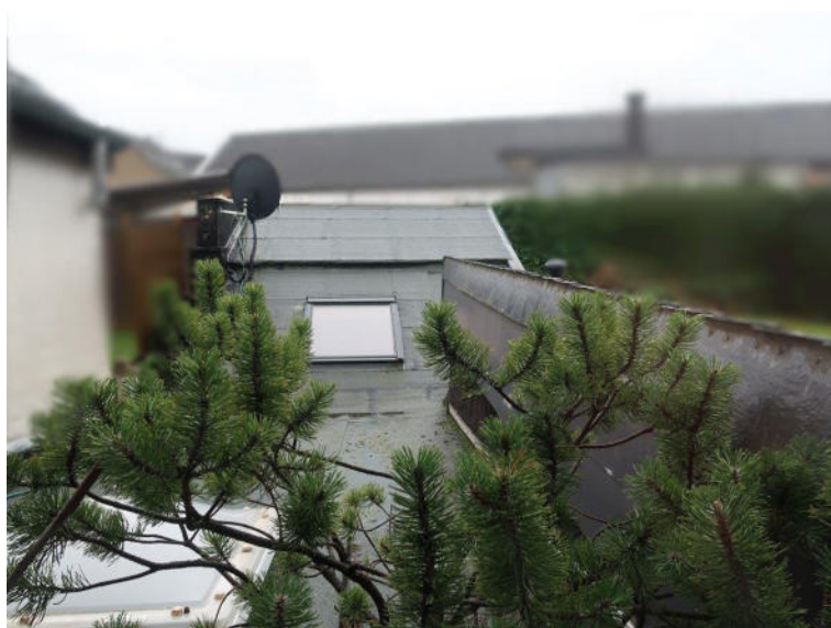
Bild 3 Blick vom OG auf die Anbauten
