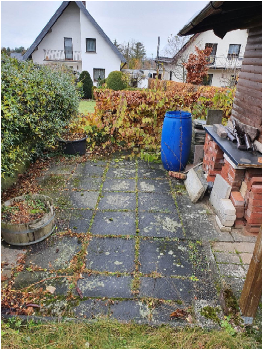
Plattenbelag neben Gartenhaus
