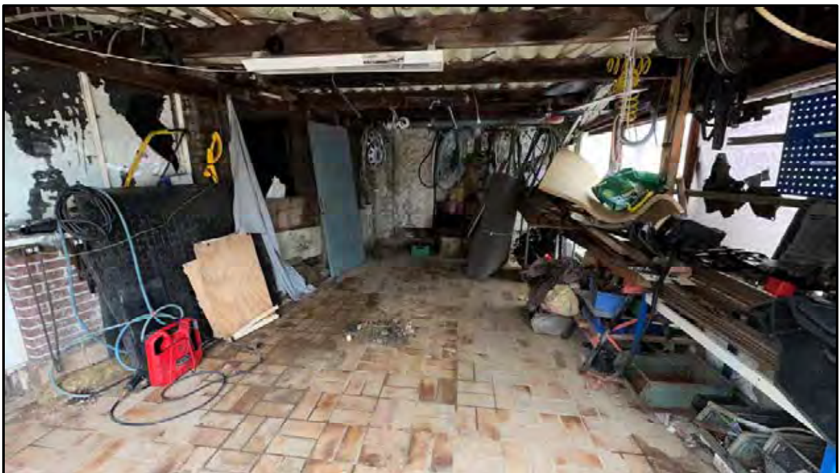
teilweise offen belassene Überdachung südlich der PKW-Doppelgarage
