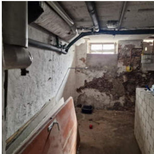
alter Öltankkeller (teilweise)
