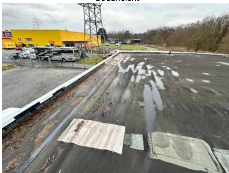
sanierungsbedürftige Dachabdichtung
