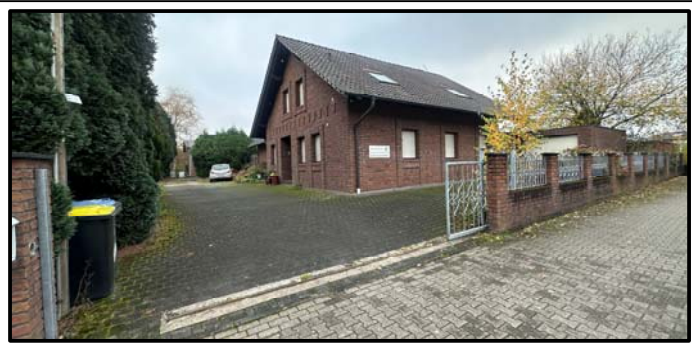
straßenseitiger Teil der Zuwegung
