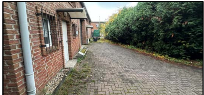
Zuwegung im Bereich der Gewerbehalle
