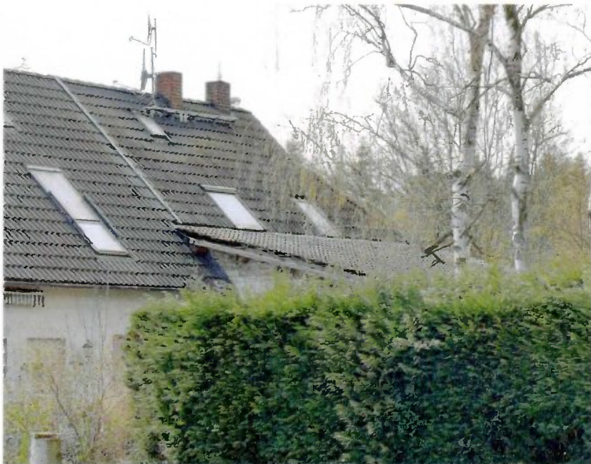
Ausschnitt augenscheinlich im Rohbauzustand befindliche Südostseite des Anbaus an der Rückfront - mit Zoom von der Wegefläche aufgenommen
