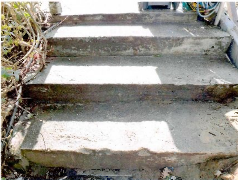
Ausgleichsstufen zum Hauseingang / zur Terrasse mit Hinweis auf unterschiedliche Steigungshöhen pp.
