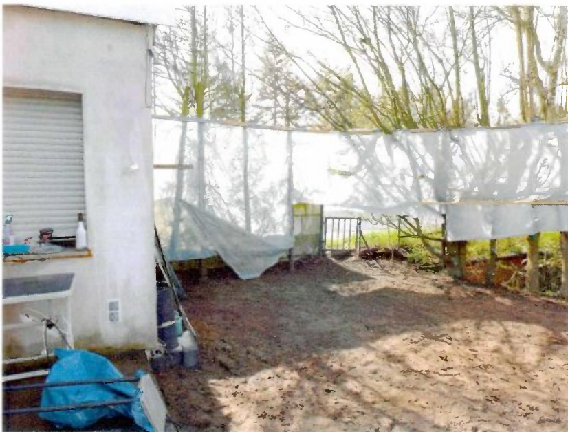
südwestlicher Grundstücksbereich Richtung B 8 mit provisorischem Sichtschutz
