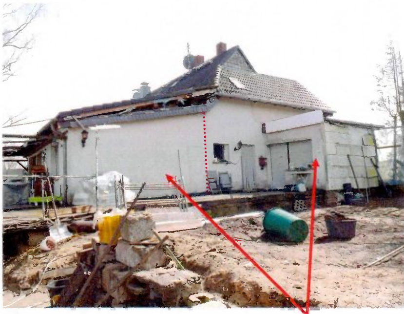
Nordwestgiebel mit Hauseingang sowie ohne Genehmigung erstellte eingeschossige Anbauten
