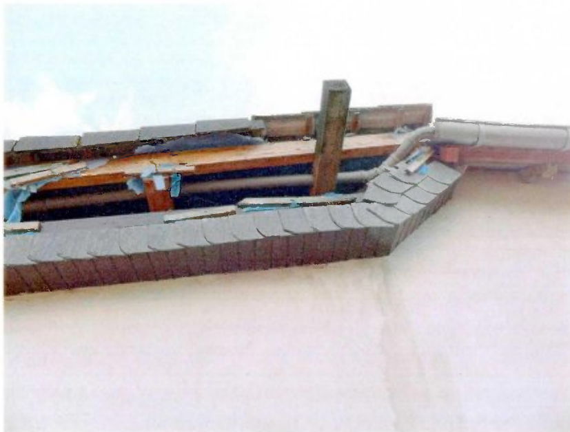
provisorisch durch die Dachkonstruktion des Anbaus verlegte Regenentwässerung
