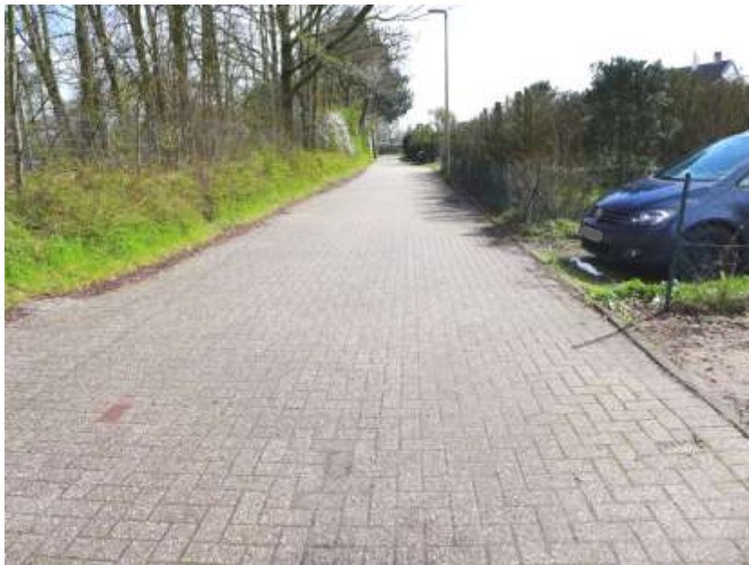
zur Reeser Landstraße führende Wegefläche
