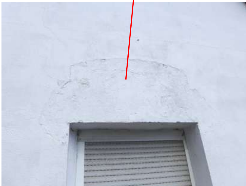
Ausschnitt Südwestseite mit Hinweis auf einfache handwerkliche Leistung von Beiputzarbeiten und leichte Rissbildungen
