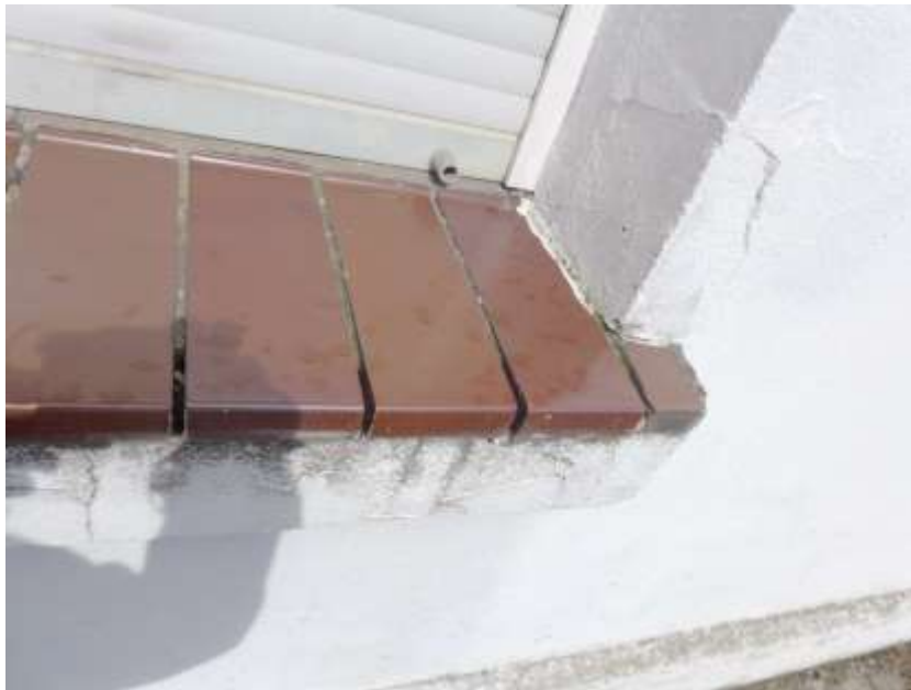
weiteres Detail Südwestseite mit ausgebrochen Fugen der Klinker und Rissbildungen pp.
