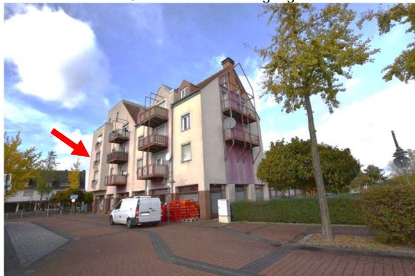
Südostansicht - Sondereigentum Nr. 19
