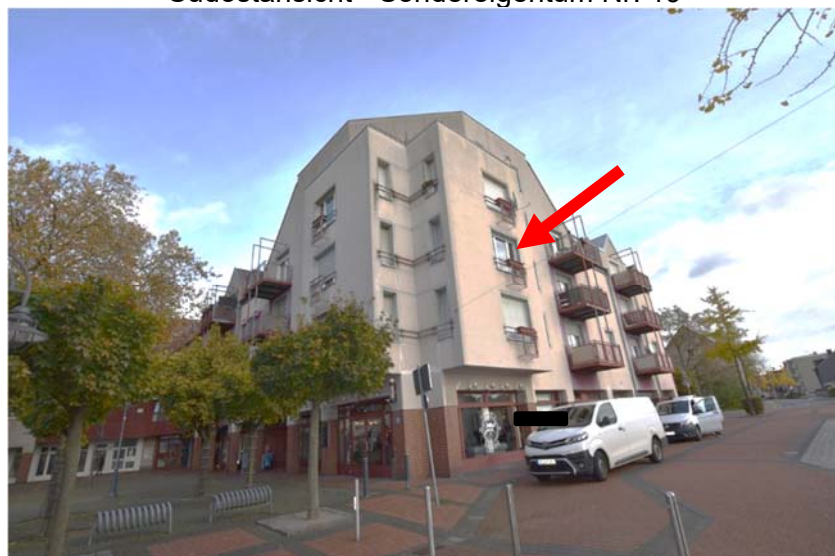
Südwestansicht – Sondereigentum Nr. 19
