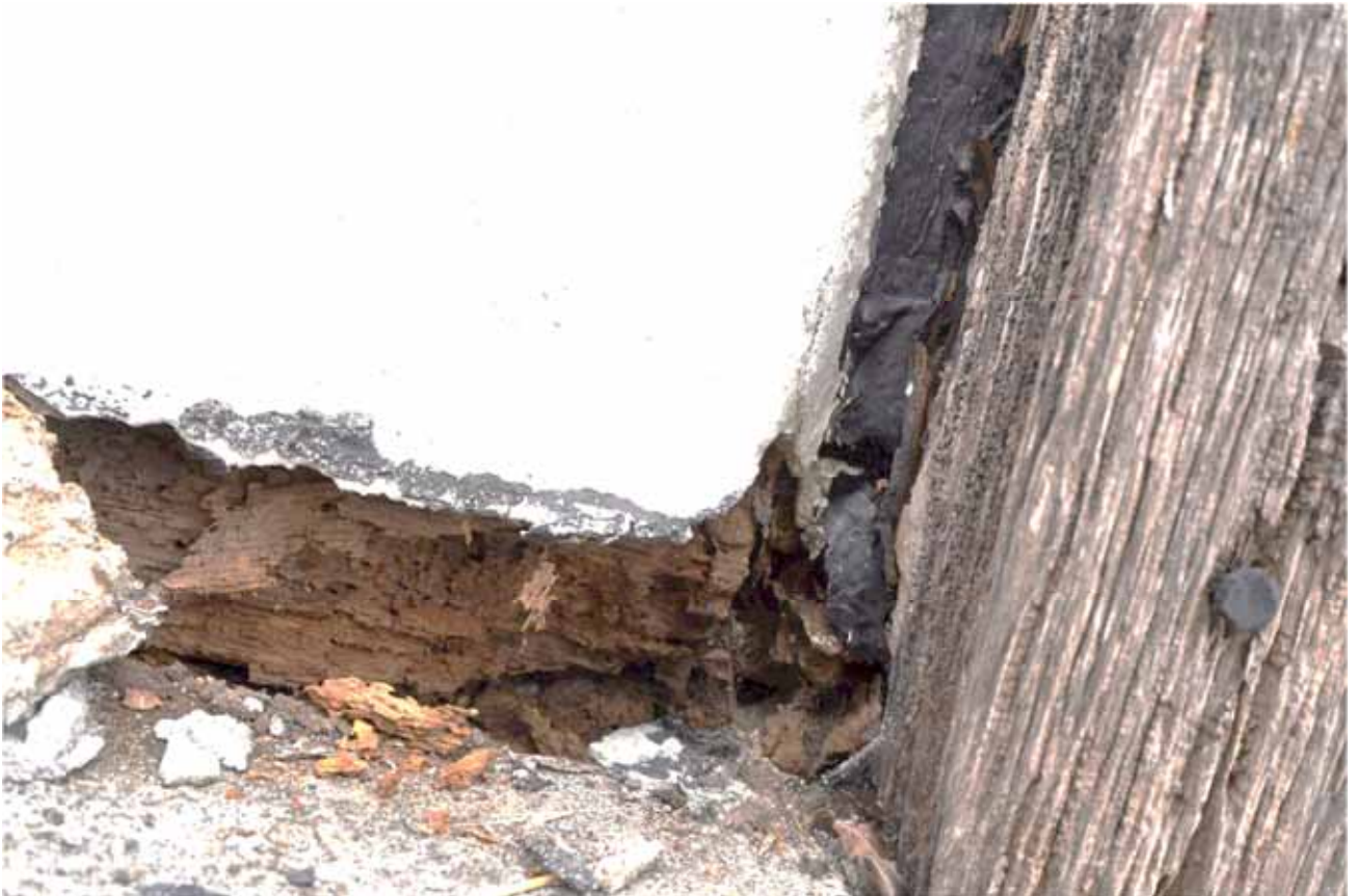
Durchgefallene Holzfachwerkkonstruktion
