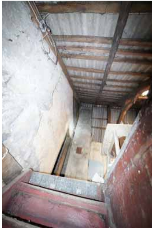
Zugang zum Dachgeschoss (keine Besichtigung)
