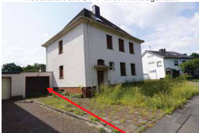
Nordostansicht und Garage BT 3
