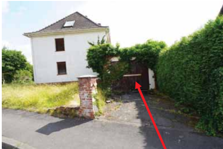
Westansicht und BT 4- ehem. Kokslagerraum
