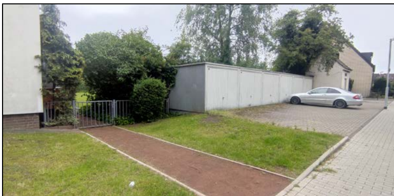
Blick auf Reihengaragen und die dahinterliegende ehemalige Trafo-Station
