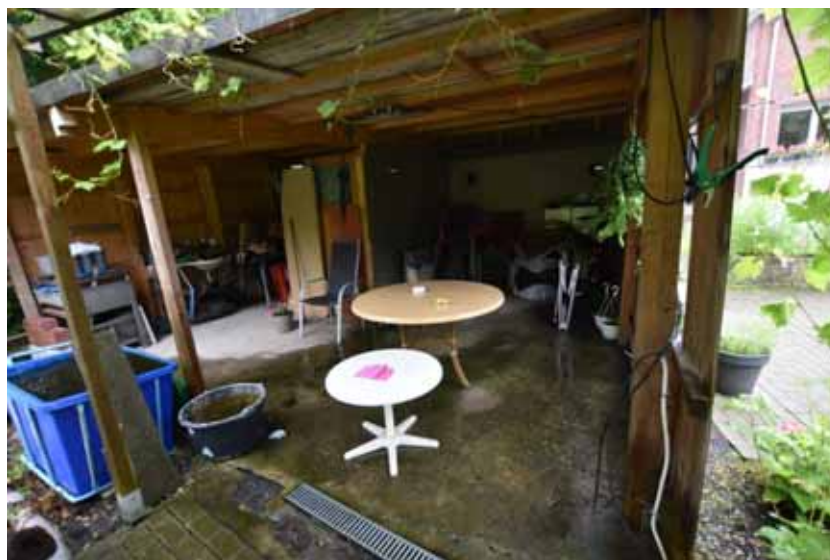
Überdachung hinter der Garage
