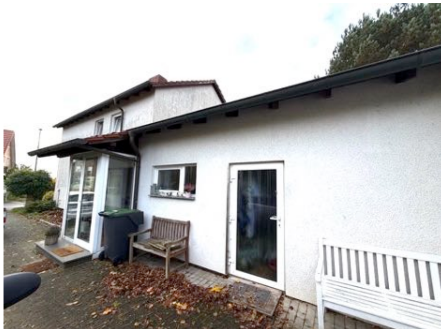
Nordansicht im Detail
