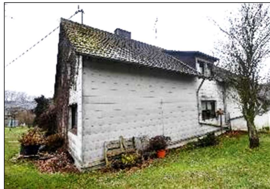
Bild 8: Ansicht Wohngebäude (Beispiel)
