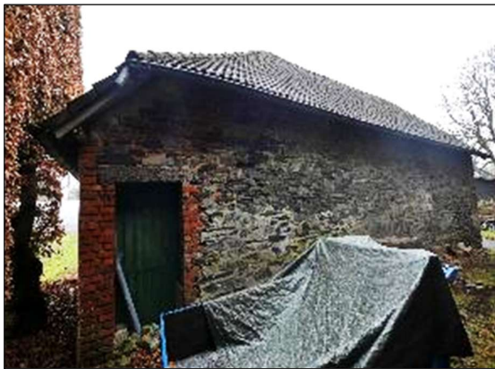
Bild 11: Ansicht ehem. Ökonomiegebäude (Beispiel)
