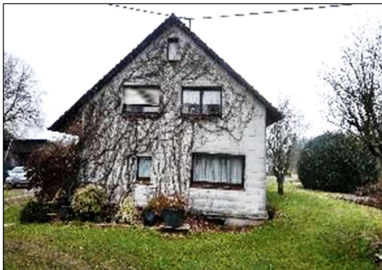
Bild 7: Ansicht Wohngebäude (Beispiel)
