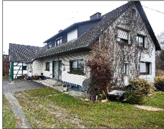
Bild 6: Ansicht Wohngebäude (Beispiel)
