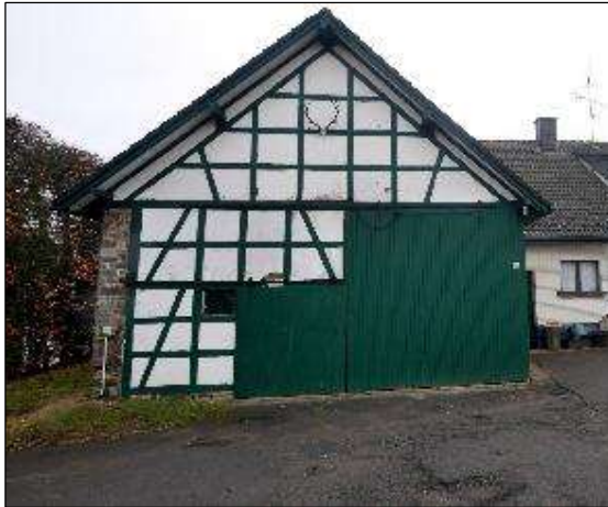
Bild 9: Ansicht ehem. Ökonomiegebäude (Beispiel)
