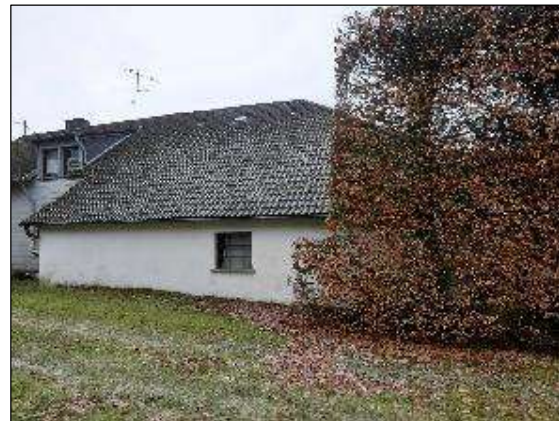
Bild 12: Ansicht ehem. Ökonomiegebäude (Beispiel)
