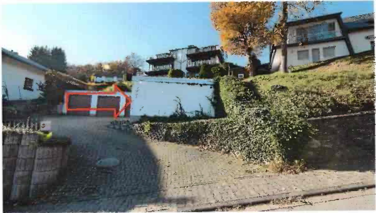
Bild 3: Zufahrt zu den Garagen vom Seerandweg aus
