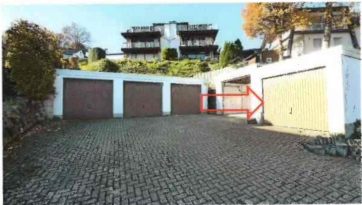
Bild 4: Ansicht der Garage (Pfeil = Garage Nr. 8)
