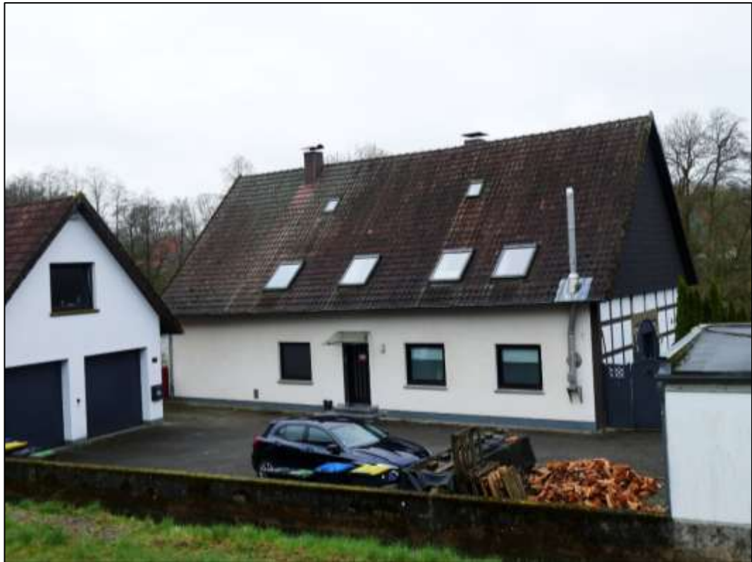
Ost-Ansicht Hauptgebäude mit Garage
