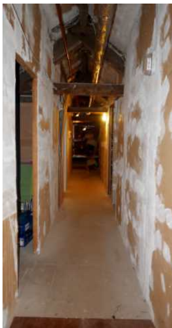
Bild 15: Innenansichten Dachgeschoss (W VI)
