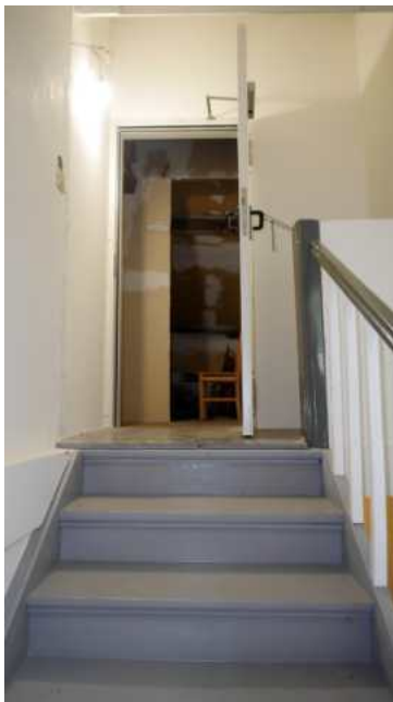
Bild 23: gemeinschaftliches Eigentum Treppenhaus mit Zugang Dach- geschoss
