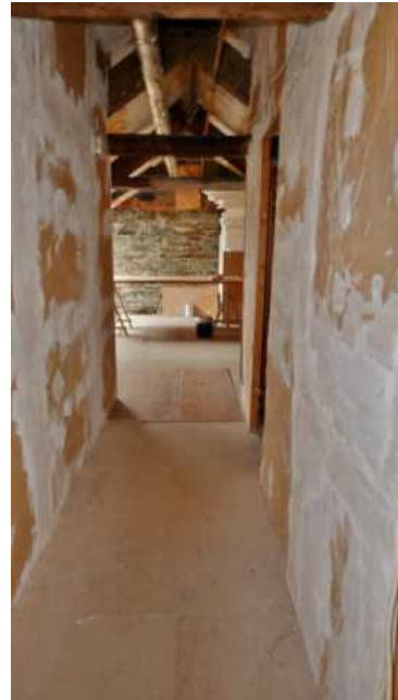
Bild 10: Innenansichten Dachgeschoss (W VI)
