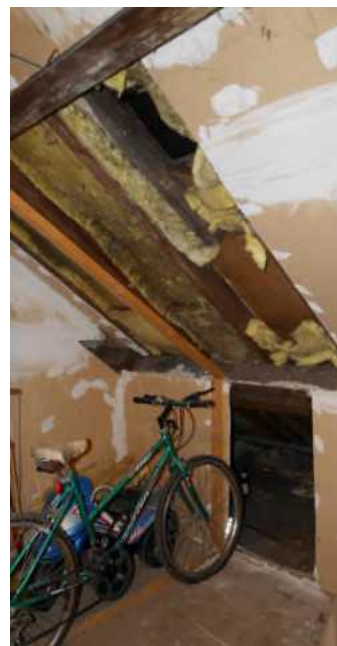
Bild 16: Innenansichten Dachgeschoss (W VI)
