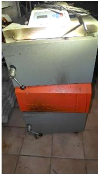
Bild 21: Haustechnik (alter Festbrennstoff- kessel, außer Betrieb)
