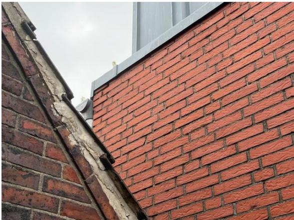
Bild 7: Fugenschäden Klinkerfassade hinterer Anbau
