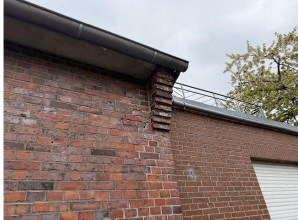
Bild 6: Fugenschäden Klinkerfassade
