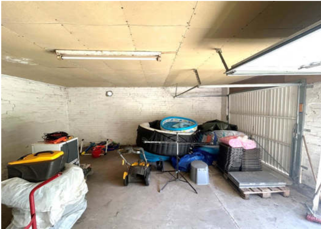
Ehemaliger Hühnerstall: Innenraum
