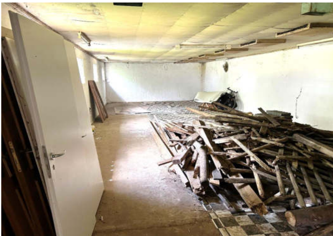
Ehemaliger Hühnerstall: Innenraum
