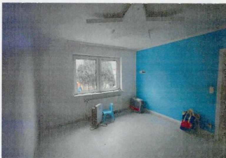
Kinderzimmer im Obergeschoss
