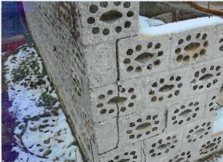
Zustand Mauer im Bereich der Terrasse
