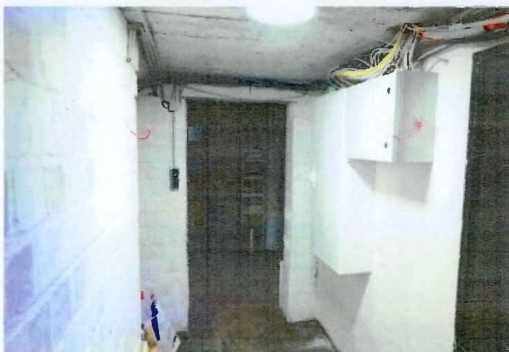
Flur im Kellergeschoss
