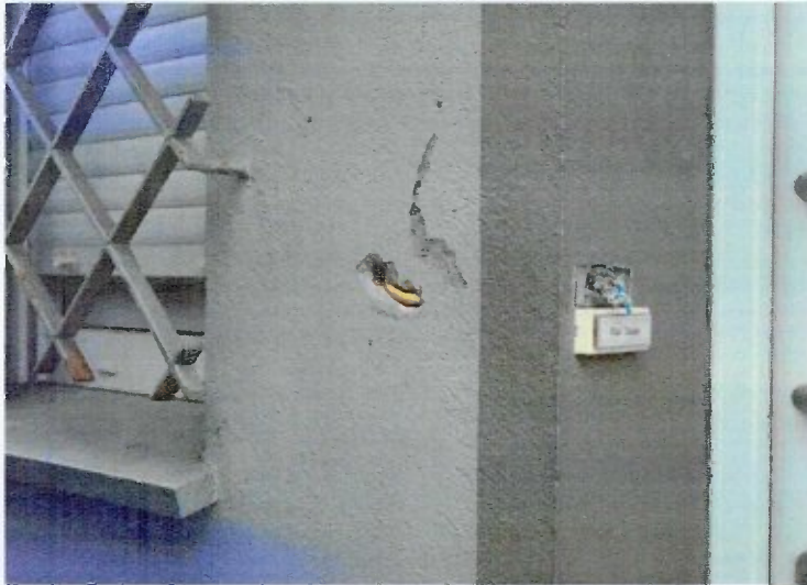
Zustand im Hauseingang
