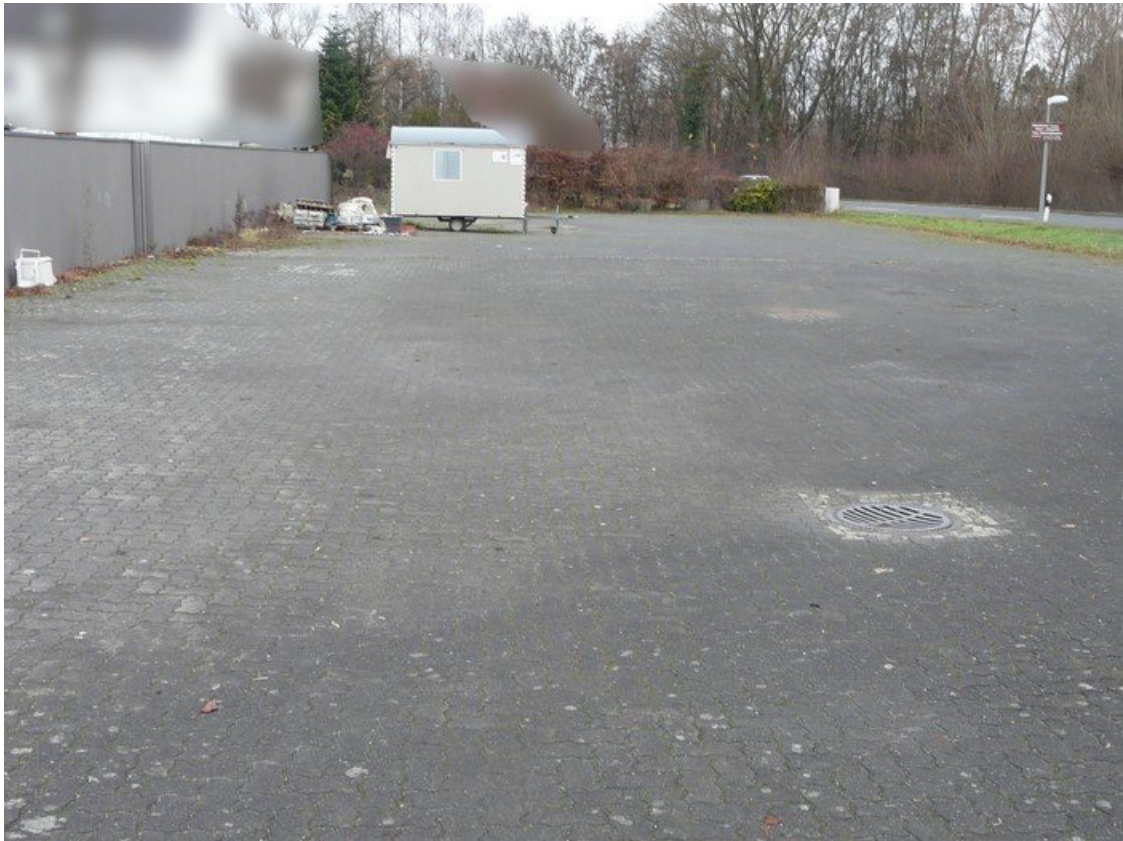
Blick in Richtung Nordosten (Stellplatzanlage)
