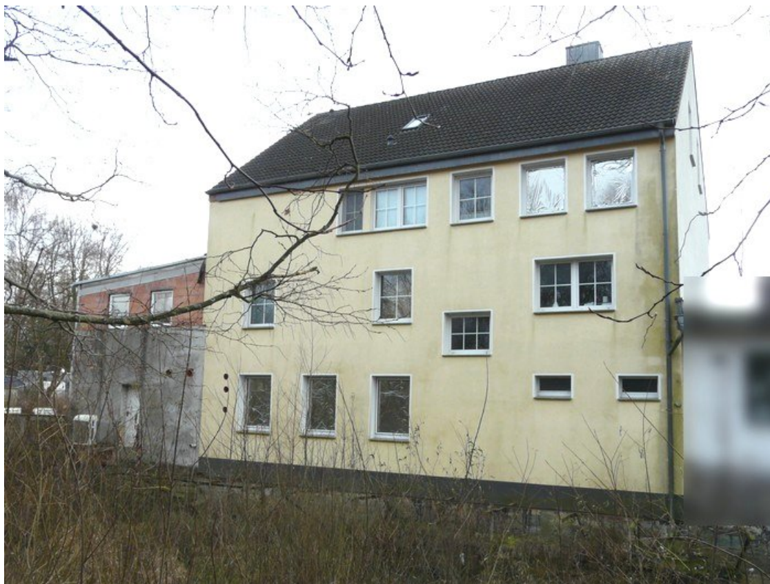
Ansicht von Norden
